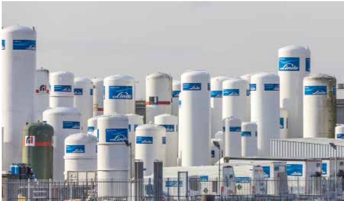
Резервуары для хранения Linde group, Schiedam-8228
