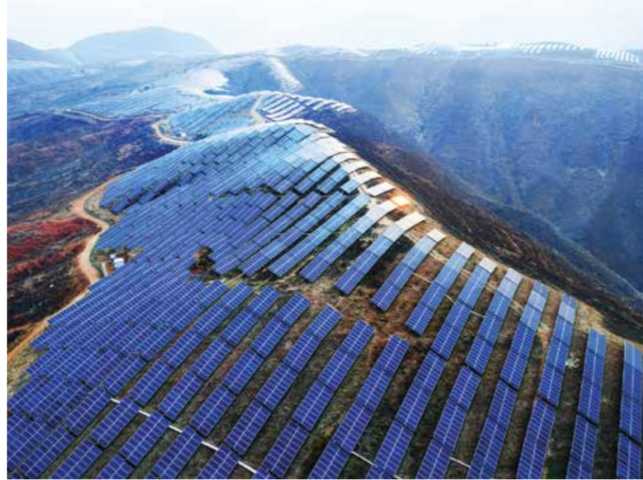
Солнечная станция Panda Green Energy. Датун, провинция Шаньси, Китай Источник: Chinalmages / depositphotos.com
