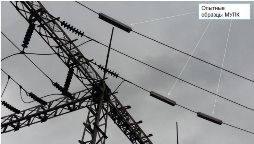
Опытные образцы МУПК на объекте ОПЭ
