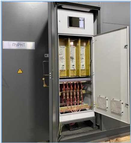
Размещение ПУРНТ на КТП (вид сверху)
