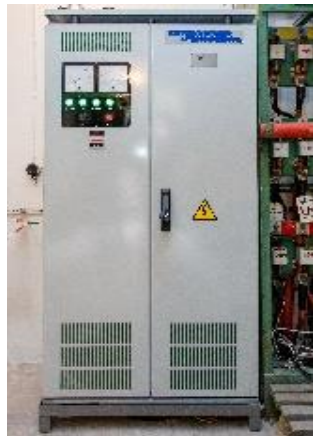
Опытно-промышленный образец ПРРМ 50квар на объекте опытно-промышленной эксплуатации в ПАО «Россети Ленэнерго»
