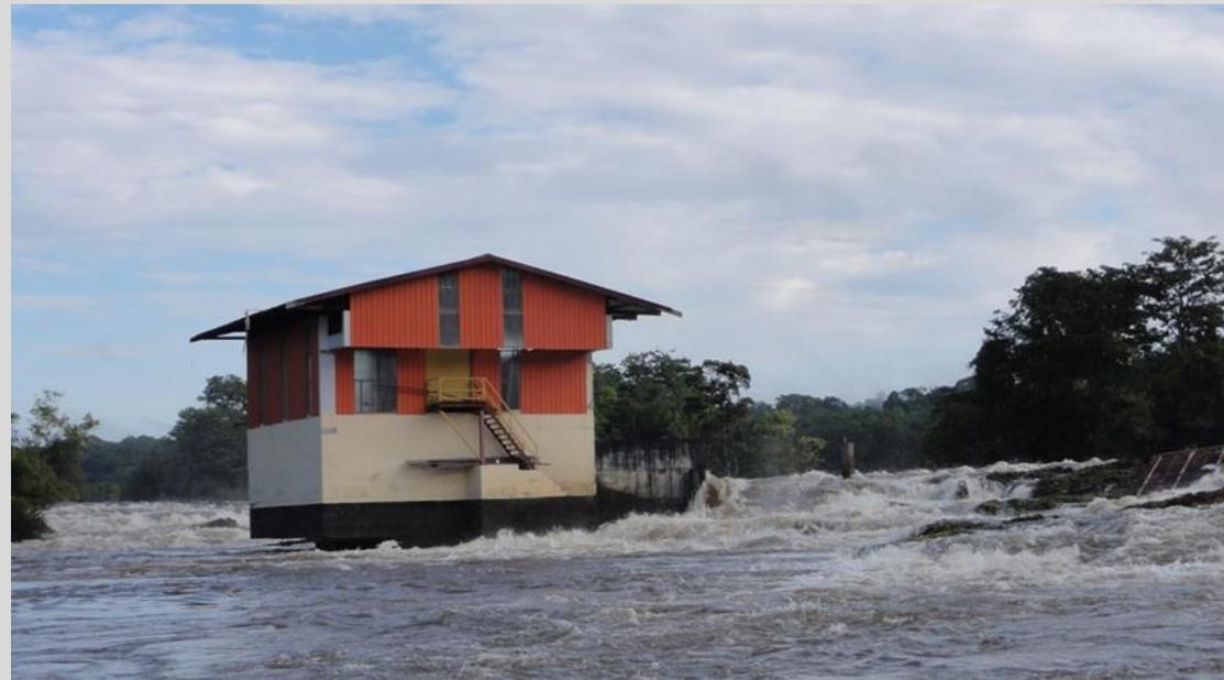
На станции установлено три гидроагрегата ГАС мощностью по 130 кВт с пропеллерной турбиной, напор 3,5 м
